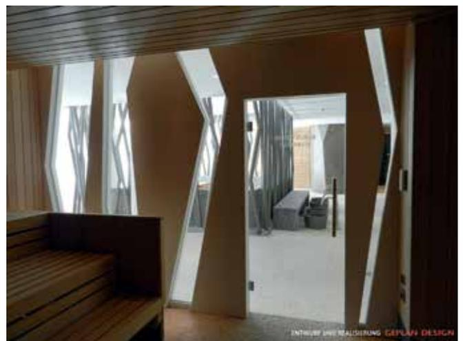
Besondere Herausforderung: Innen Bio Sauna bis 120° Grad möglich, Aussentemperatur ca. 25° Grad. Sandwichkonstruktion mit spez. Glas. Konturen der HI-MACS® Formen wurden im Glas mit Folie passgenau abgeklebt. Farbe: HI-MACS® Alpine White S28.
